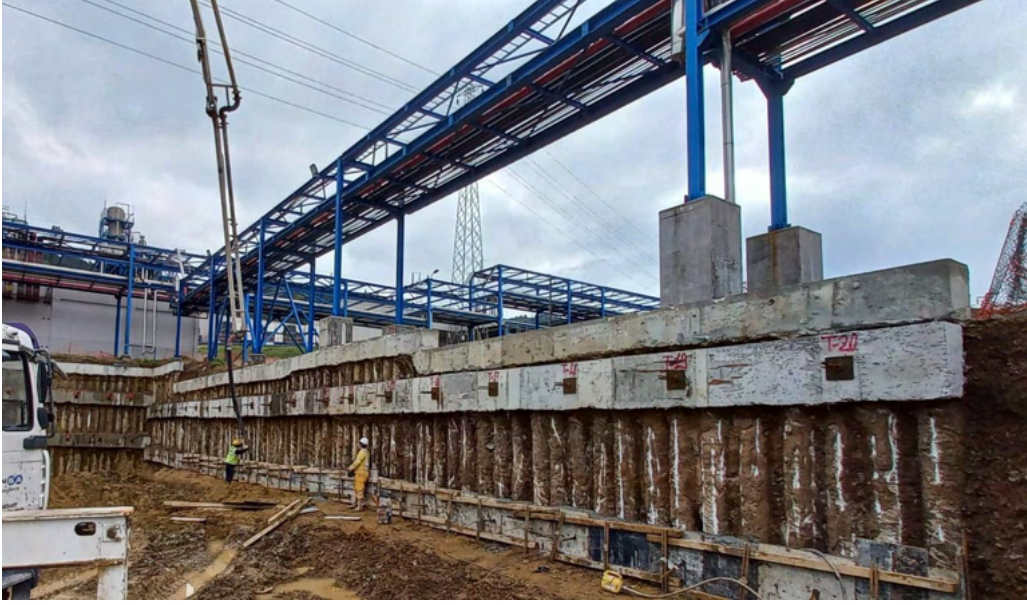
Şekil 3.37. Tie-back imalat aksında kuşak kirişi betonu dökme işlemi (Öçal kişisel arşiv, 2022)
