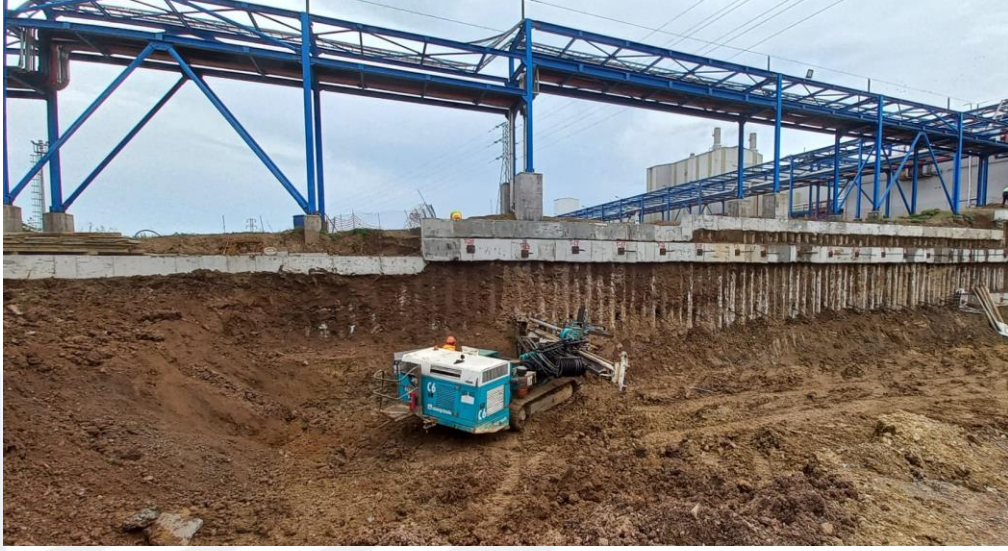
Şekil 3.31. Bir yapı etrafında tie-back elemanlar ile teşkil edilen örnek bir iksa sistemi çalışması (Öçal Kişisel Arşiv, 2022)
