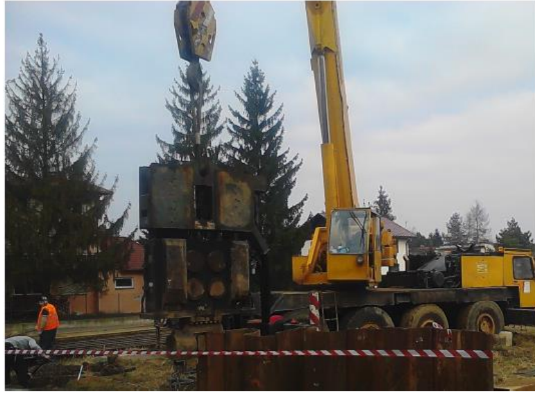
Şekil 3.12. Örnek bir palplanş imalatı (Baca, 2017)
