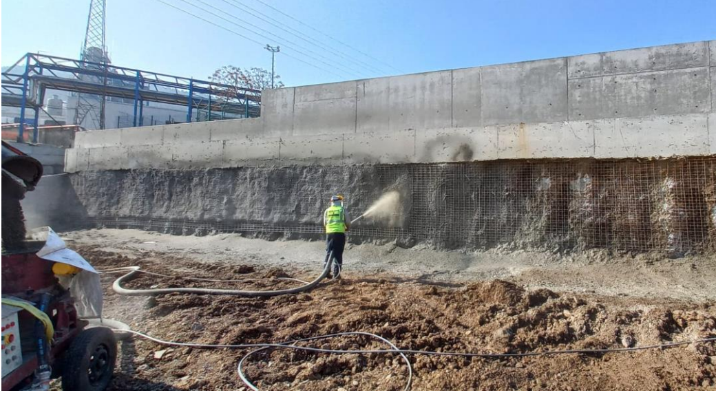
Şekil 3.18. Örnek bir püskürtme beton imalatı (Öçal Kişisel Arşiv, 2022)
