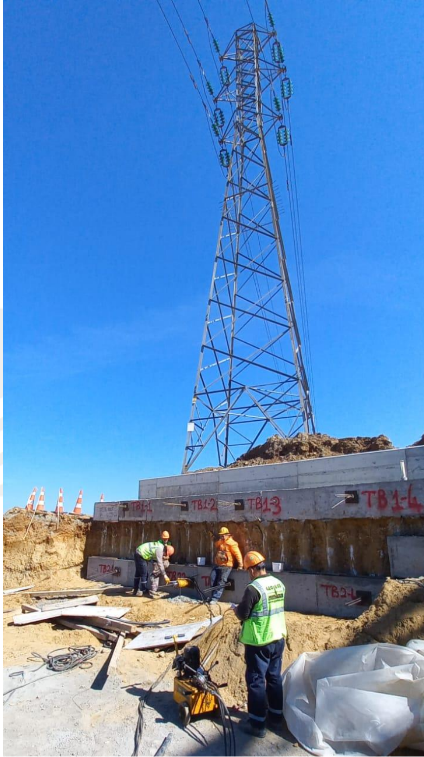
Şekil 3.30. Yüksek gerilim hattı direği etrafında tie-back kullanılan bir derin kazı (Öçal kişisel arşiv, 2022)
