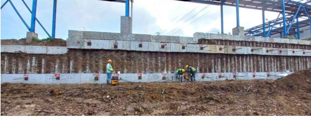
Şekil 3.38. Tie-back öngerme işlemi (Öçal kişisel arşiv, 2022)
