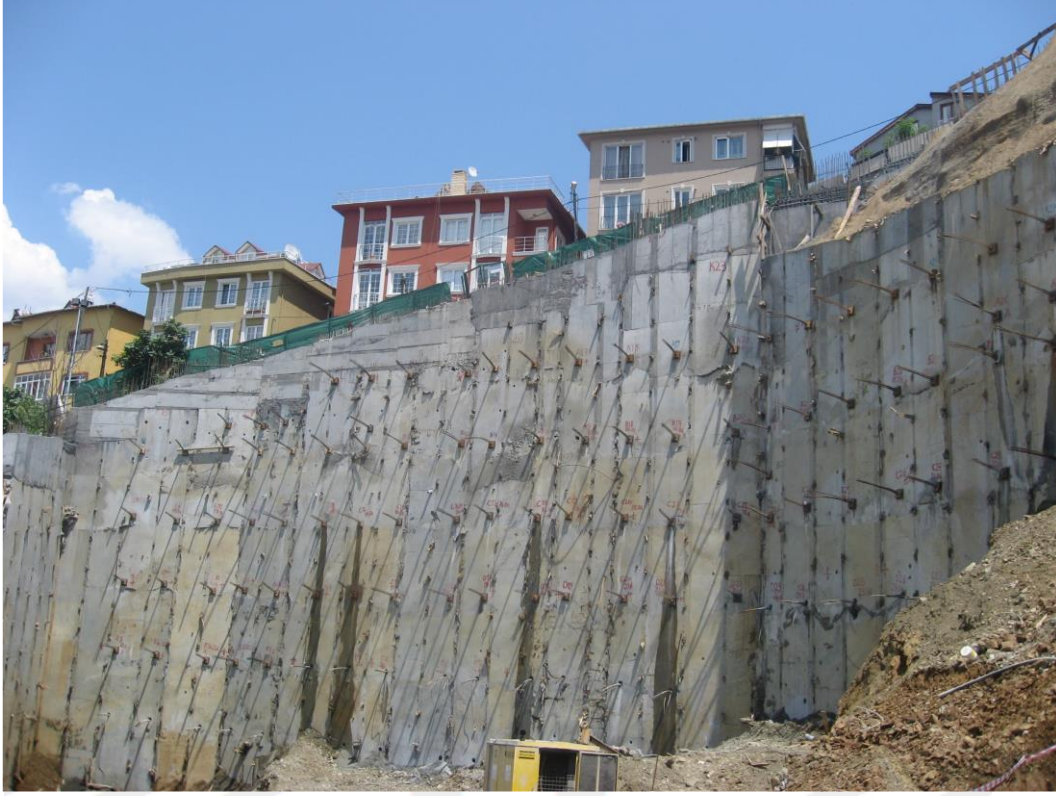
Şekil 3.13. Tamamlanmış bir kuyu perde imalatı (Köse, 2010)
