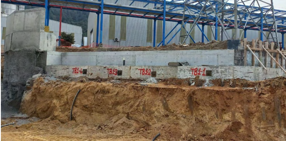
Şekil 3.33. Tie-back çalışması yapılmış bir çalışma platformu (Öçal kişisel arşiv, 2022)
