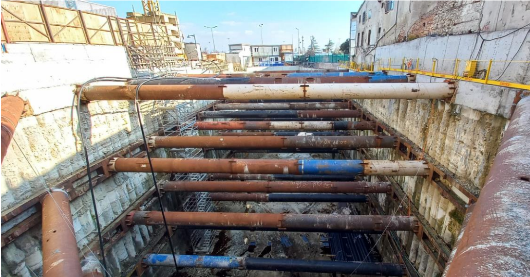
Şekil 3.19. Örnek bir içten iksalı destekleme sistemi (Öçal Kişisel Arşiv, 2022)
