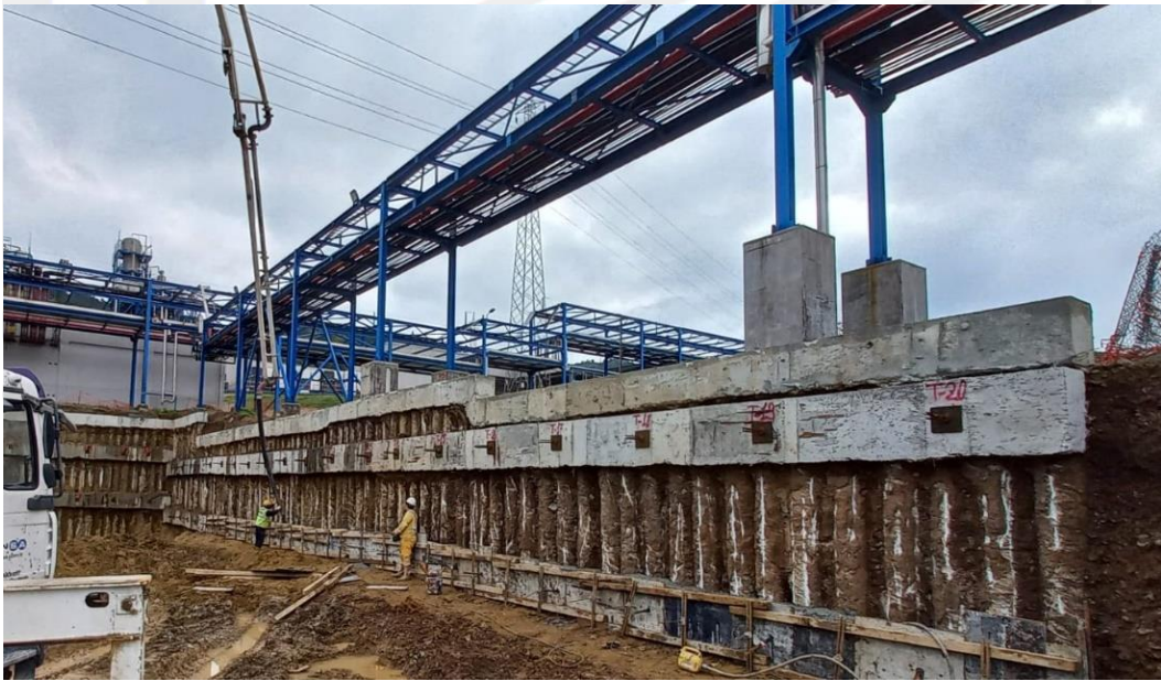
Şekil 4.1. alışma sahasında yer alan boru köprüsü iksa sistemi (Öal kişisel arşiv, 2022)
