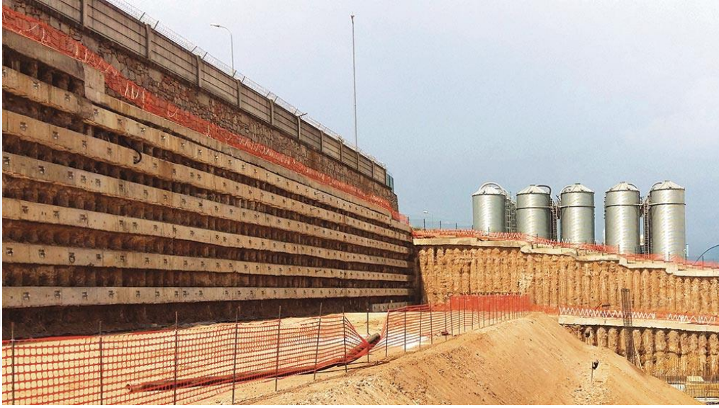
Şekil 3.15. Fore kazıkların kullanıldığı örnek bir iksa çalışması
