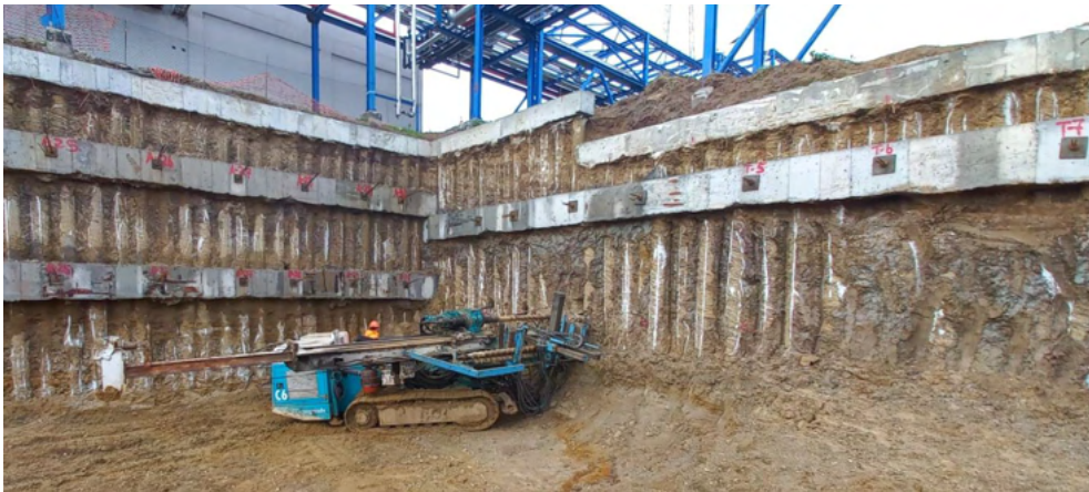
Şekil 3.35. Tie-back aplikasyon noktasına yanaşmış delgi makinesi (Öçal kişisel arşiv, 2022)
