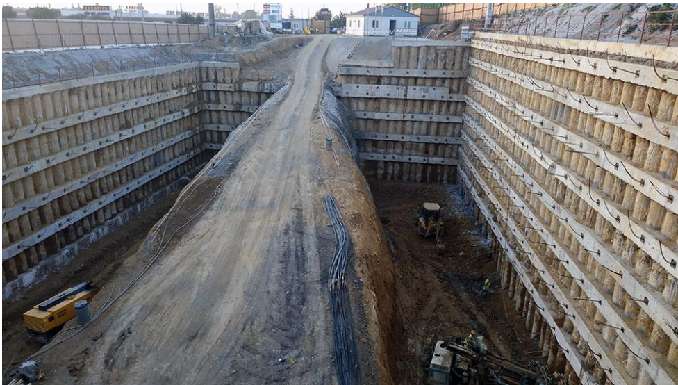
Şekil 3.8. Öngermeli ankrajların kullanıldığı örnek bir iksa sistemi
