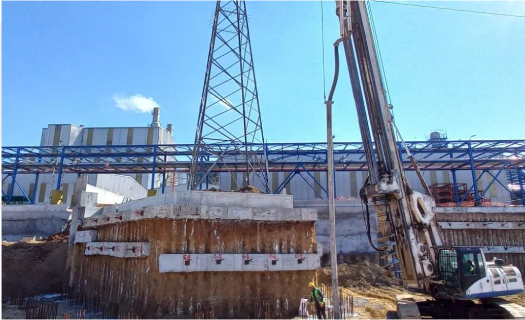
Şekil 4.2. İksa hattı ile çakışan elektrik direği için alınan iksa önlemi (Öçal kişisel arşiv, 2022)
