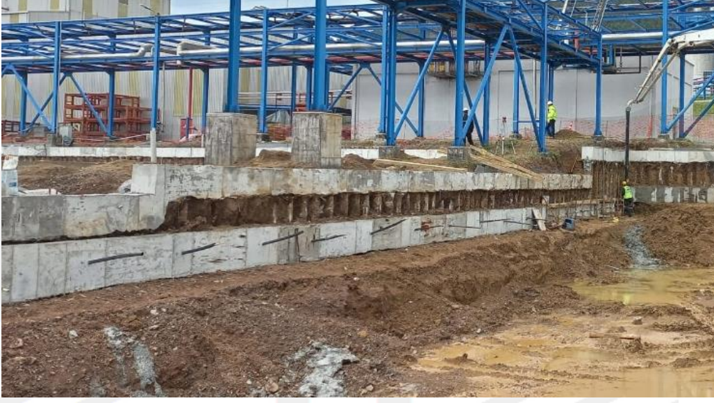
Şekil 3.36. Koruma boruları içinde öngerme işlemine hazır tie-back elemanlar (Öçal kişisel arşiv, 2022)
