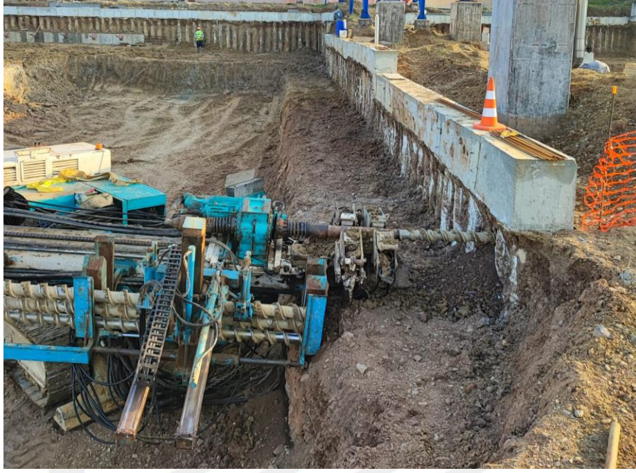
Şekil 3.34. Tie-back imalatı için hazırlanmış bir çalışma platformu (Öçal kişisel arşiv, 2022)
