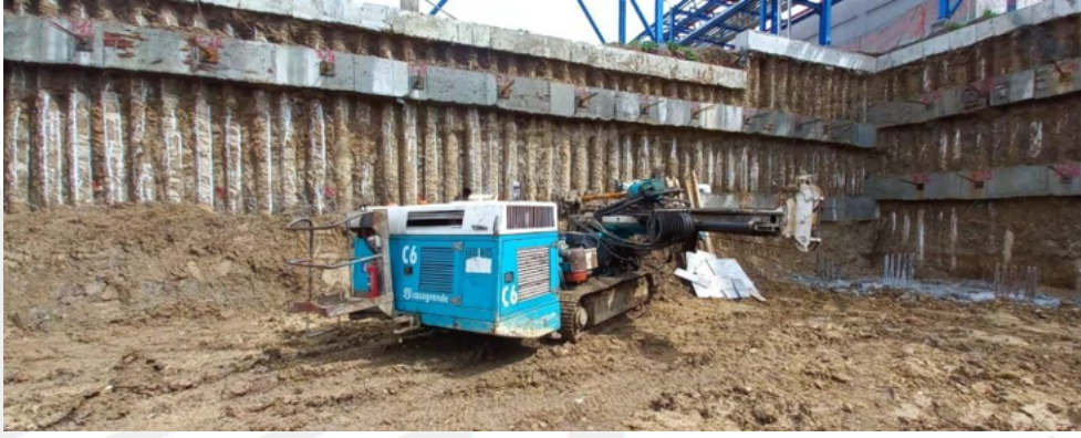
Şekil 3.29. Tie-back kullanılmış örnek bir iksa çalışması (Öçal kişisel arşiv, 2022)
